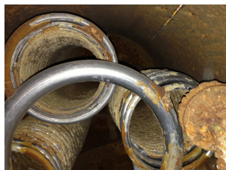
Tilkalkede varmespiraler i en stor VVB
